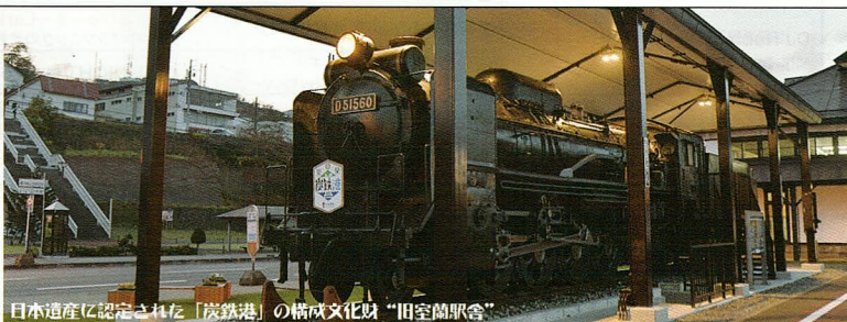
日本遺産に認定された「炭鉄港」の構成文化財「旧室蘭駅舎」
